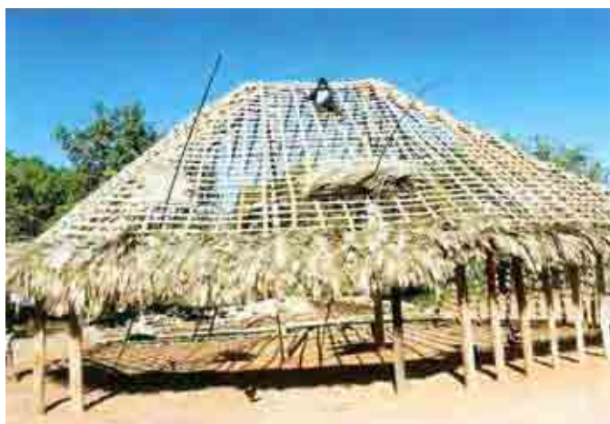
Foto. nº. 33 – (Kelly Russo) – construção da casa doméstica atualmente
