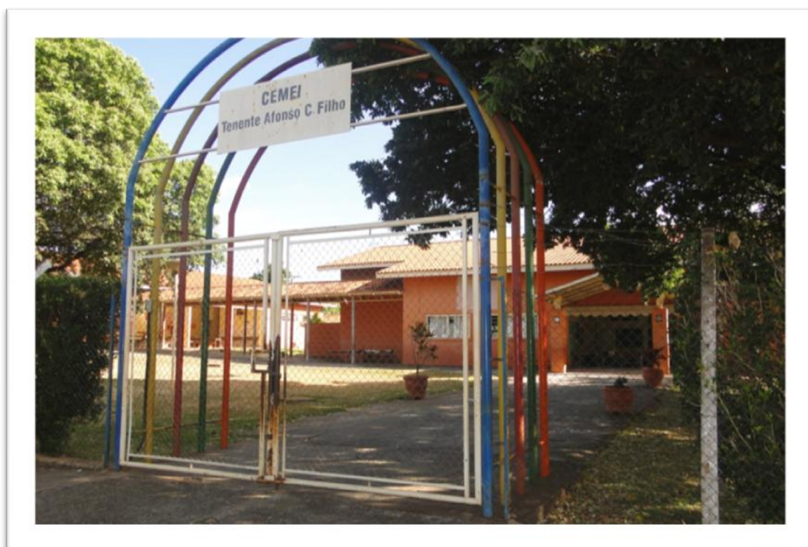
Figura 6: Foto da fachada do CEMEI “Tenente Afonso Câmara Filho”
