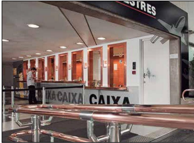
Figura 11: Corrimão e guichês revestidos em cobre no Aeroporto de Congonhas
