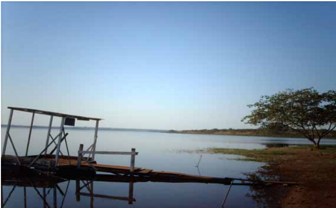
Figura 2: Represa da Usina Hidrelétrica de Furnas/Marimbondo.
