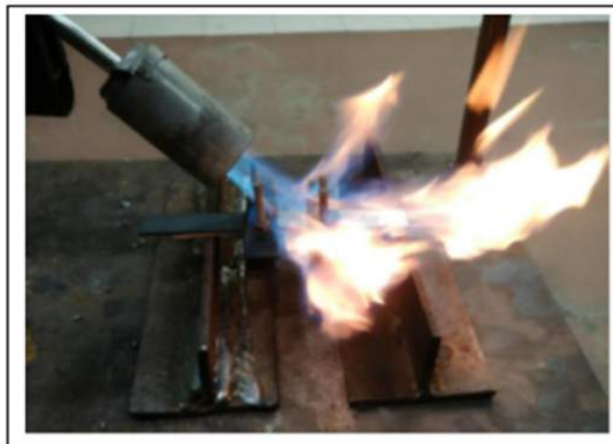
Figura 13 - Processo de soldagem por oxi-combustível.
