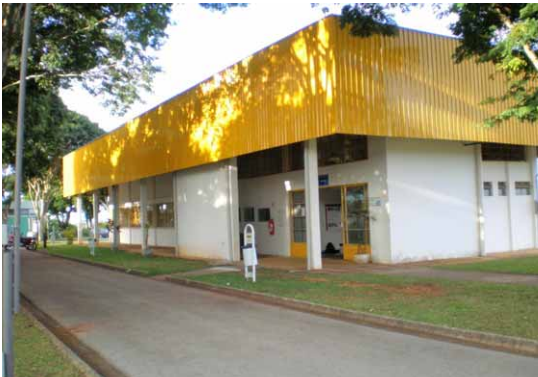
Figura 19 - Vista da biblioteca do campus Unesp em Itapeva
