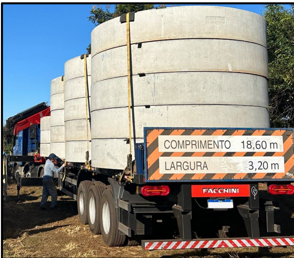
Figura 11. Aduelas utilizadas nos tanques sendo transportadas.
