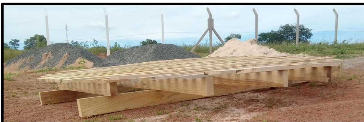
Figura 13. Suporte em madeira para limitar área dos anéis.
