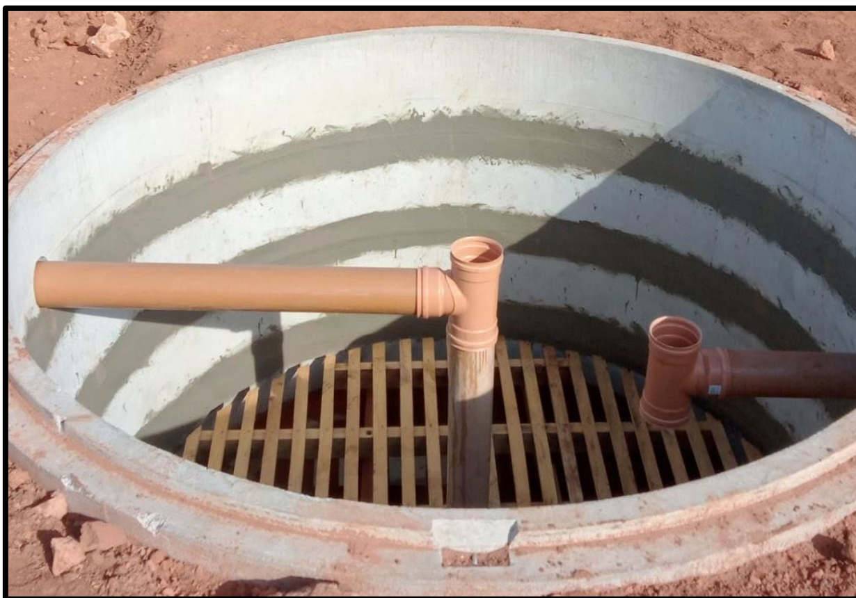
Figura 12. Instalação das aduelas utilizadas nos tanques.
