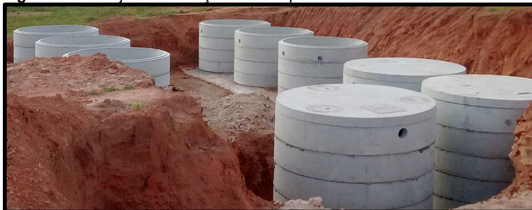
Figura 16. Arranjo da instalação dos tanques da ETE.
