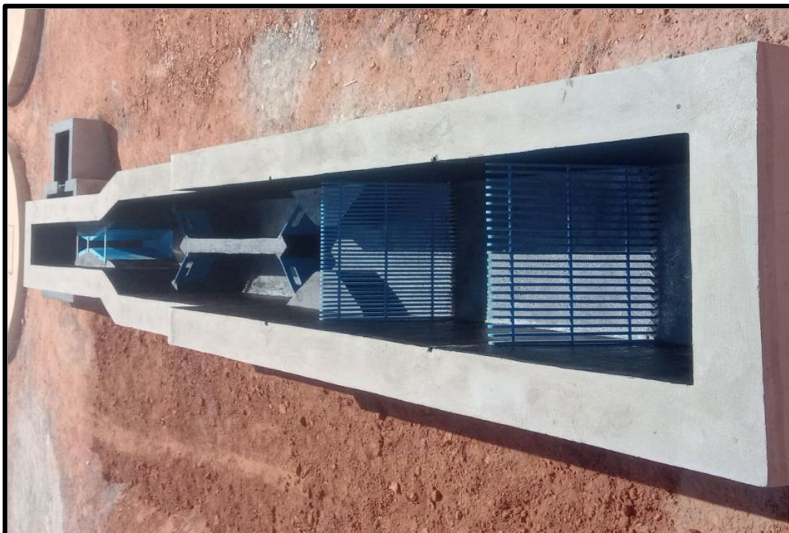
Figura 15. Pré-tratamento e acabamentos de execução.
