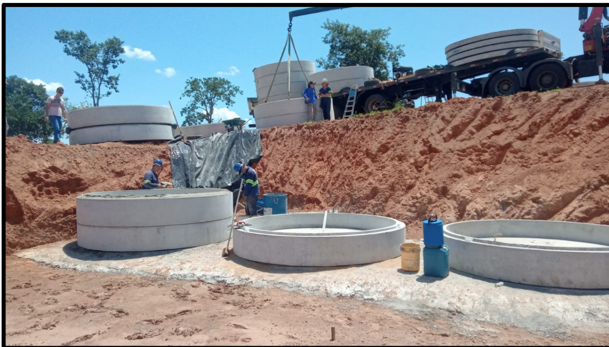
Figura 10. Base de concreto e início da instalação dos fundos dos tanques.
