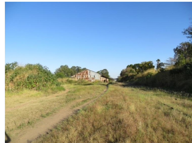
Figura 23 – Vista do pátio de manobras da ferrovia e ao lado o galpão de estocagem. Foto: GAVAZZI, M. (2014). Fonte: Arquivo pessoal.
