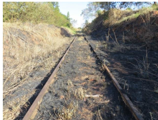
Figura 19 – Foto do trecho urbano da linha férrea referente ao trecho do Jd. Adamantina, após incêndio provocado pela própria população do entorno. Foto: GAVAZZI, M. (2014). Fonte: Arquivo pessoal.
