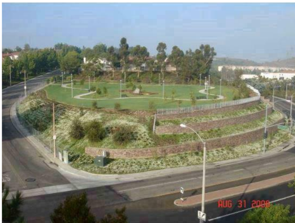
Figura 14 - Subestação Anaheim instalada do subsolo do Parque Roosevelt nos EUA
