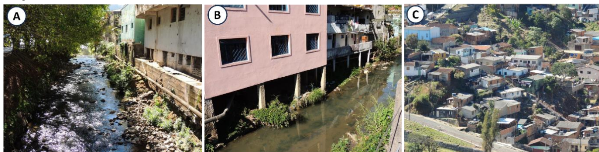
Figura 30 – Visão parcial dos setores 13 e 18 (risco geológico-geotécnico) no município de Poços de Caldas – MG
