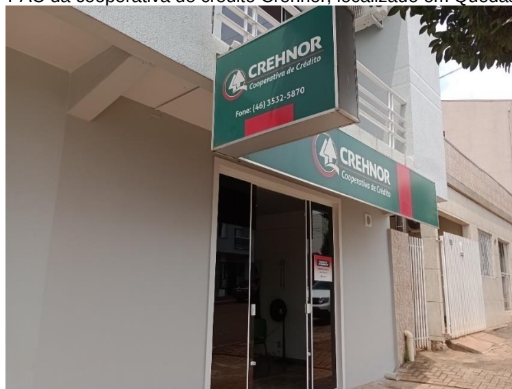
Foto 15 – PAC da cooperativa de crédito Crehnor, localizado em Quedas do Iguaçu
