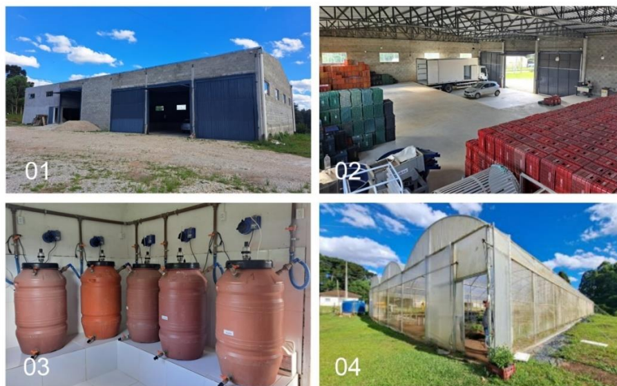
Painel Fotográfico 7 – Infraestruturas da cooperativa Terra Livre, assentamento Contestado, Lapa
