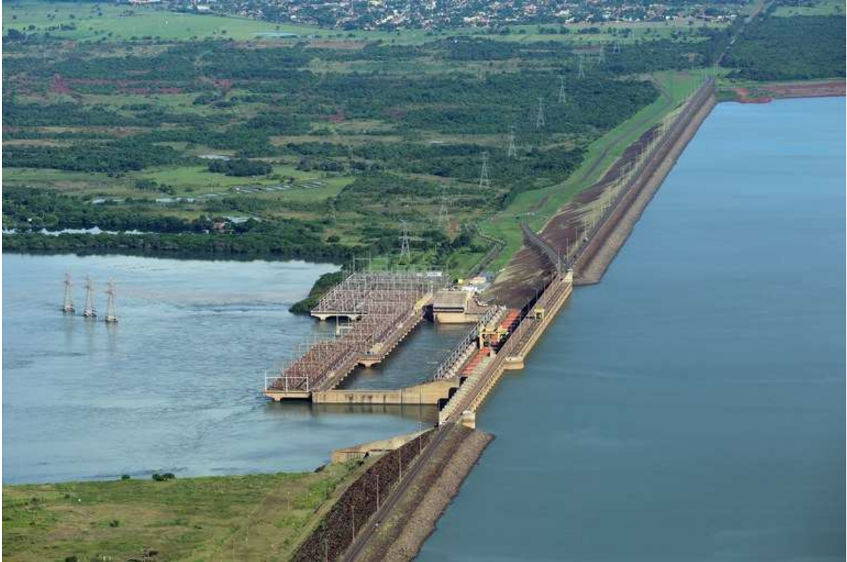
Figura 2 – Barragem da Usina Hidrelétrica Ilha Solteira (UHE Ilha Solteira) no rio Paraná na divisa entre Ilha Solteira (SP) e Selvíria (MS)
