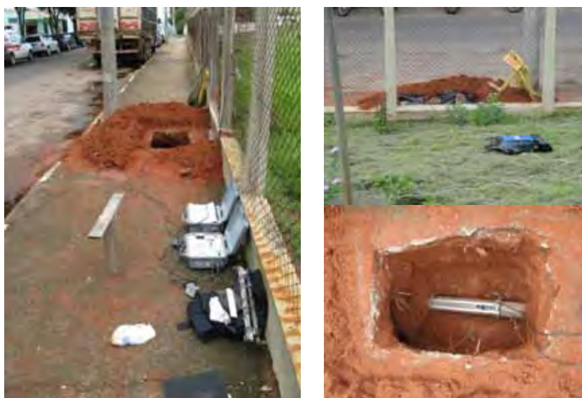
Figura 98 – Instalação do medidor de vazão
