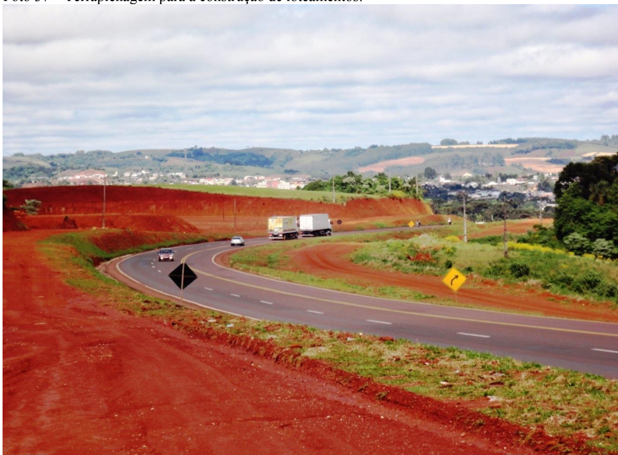
Foto 37 – Terraplenagem para a construção de loteamentos.
