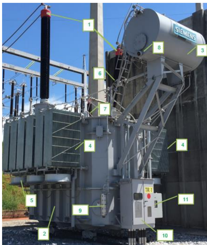
Figura 8 - Transformador de potência monofásico e seus principais acessórios
