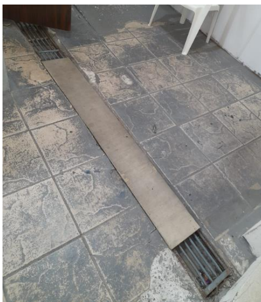
Figura 33 – Vão que atrapalha a circulação das cadeiras de rodas.
