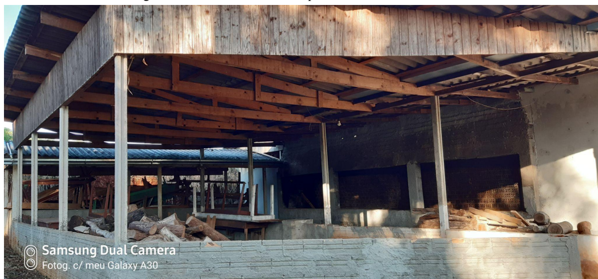
Figura 42 -Estrutura em madeira para fechamento das tesouras .
