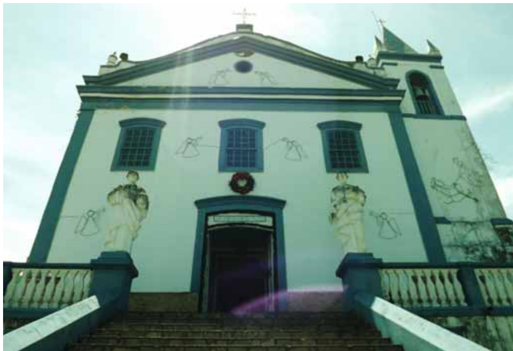
Figura 25 Fachada da Matriz Nossa Senhora D'Ajuda e Bom Sucesso. Restauração de Alfredo Olini, década de 1950. Ilhabela
