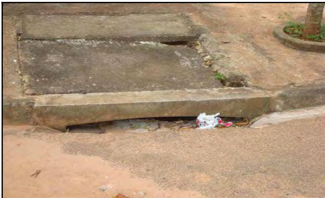
Figura 7.2 – Galeria de água pluvial (Bairro San Fernando Vally – Assis/SP) Foto: E. C. Oliveira, mar./2009
