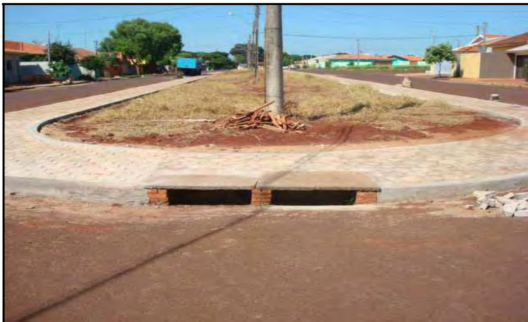
Figura 7.5 – Galeria de água pluvial (Jd. Dona Elídia – Palmital/SP) Foto: E. C. Oliveira, abr./2009
