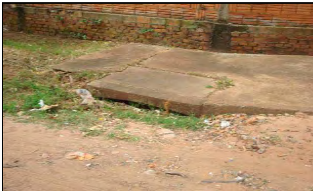
Figura 7.3 – Galeria de água pluvial (Bairro San Fernando Vally – Assis/SP) Foto: E. C. Oliveira, mar./2009
