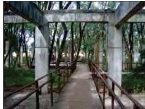
Figura 11: Ruínas dos blocos prisionais não concluídos Fonte: Acervo particular (maio de 2012)
