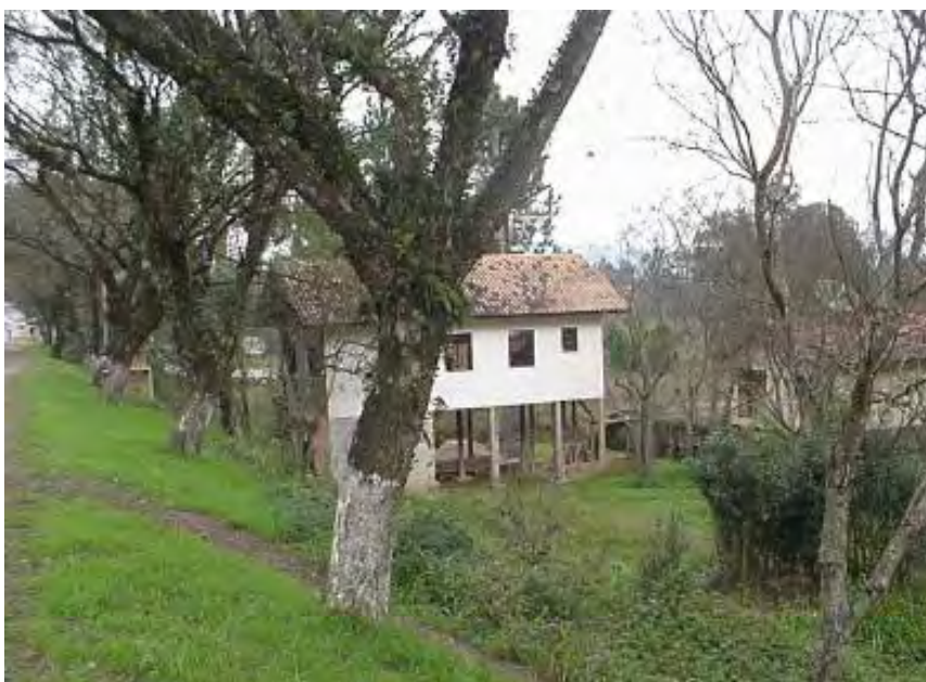
Figura 11 – Construções à prova de enchentes. (ANA, 2002)
