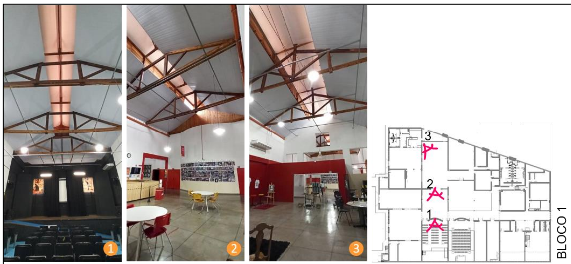
Figura 79 - Forro de PVC instalado seguindo a inclinação do telhado original da I.R.F. Matarazzo (Bloco 1)
