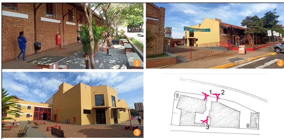
Figura 85 - Alterações e novas edificações executadas durante a intervenção da antiga I.R.F. Matarazzo
