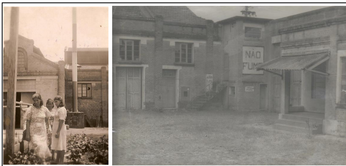
Figura 42 - Parte da fachada principal da I.R.F.Matarazzo em 1942 com coberturas em lanternim e parte da fachada principal em 1985 mostrando a telha sem o lanternim.
