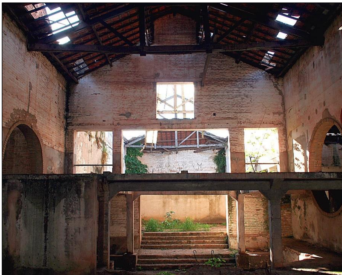
Figura 59 - Área interna do Bloco 2 em 2006. Base das Prensas.
