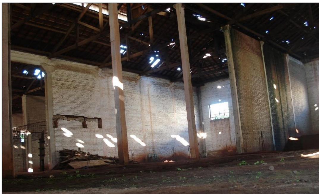
Figura 43 - Área interna do Bloco 1 antes da intervenção, 2006.
