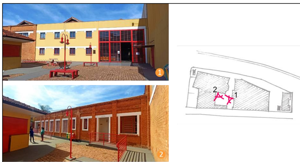
Figura 91 - Fachada do Bloco 3 e anexo após a intervenção
