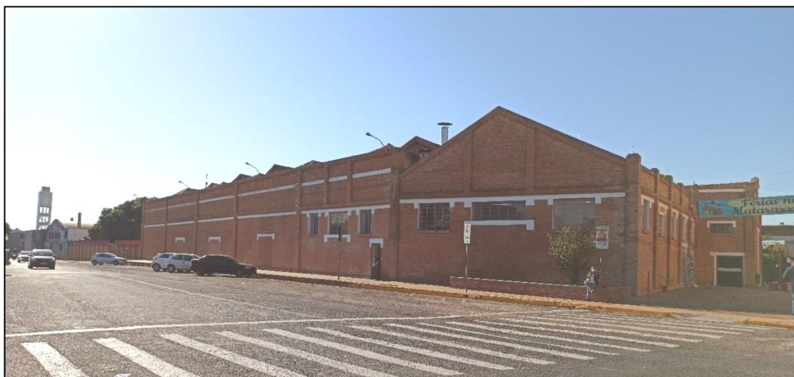
Figura 75 - Fachada noroeste do Bloco 1 depois da intervenção
