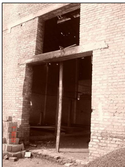
Figura 46 - Detalhe da fachada norte Bloco 1 mostrando a soleira de tijolo maciço junto da porta.
