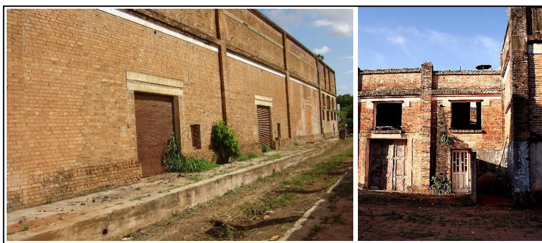
Figura 47 - Detalhe das fachadas norte e sul mostrando as esquadrias do Bloco 1 antes da intervenção, 2006.
