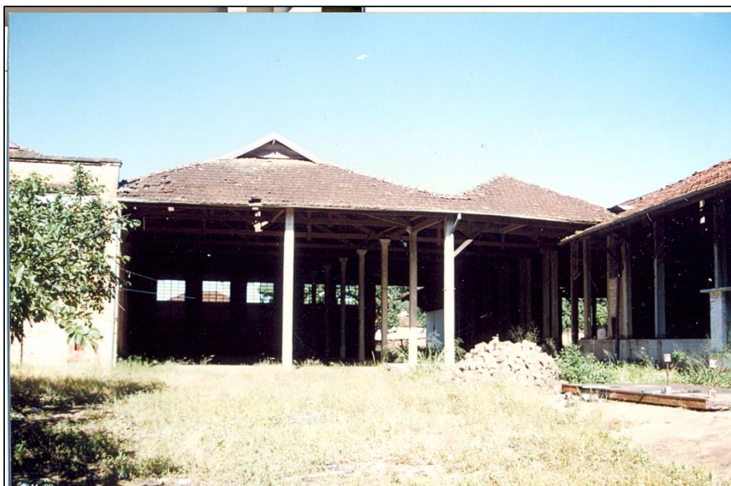
Figura 53 - Parte da fachada do Bloco 3 em 1998.
