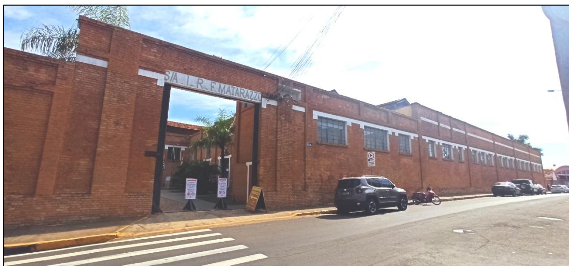
Figura 65 - Fachada Principal da I.R.F. Matarazzo da Rua Quintino Bocaiúva
