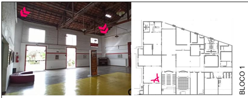
Figura 81 - Condutores de água e bonecas executados na Sala de Exposição secundária do Bloco 1
