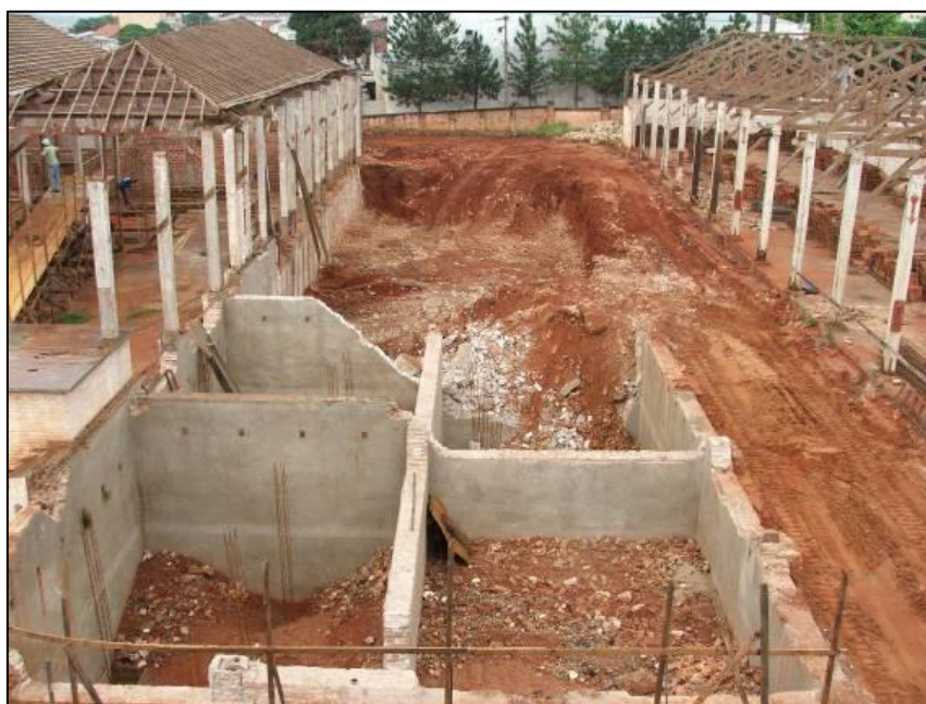
Figura 83 - Demolição das telhas para construção do Teatro Paulo Roberto Lisboa
