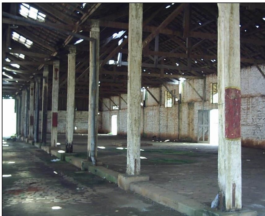
Figura 50 - Detalhe da estrutura da área interna do Bloco 2 antes da intervenção, 2006.
