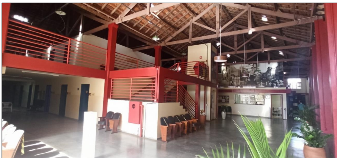
Figura 93 - Imagem da escada de acesso ao mezanino do Bloco 3
