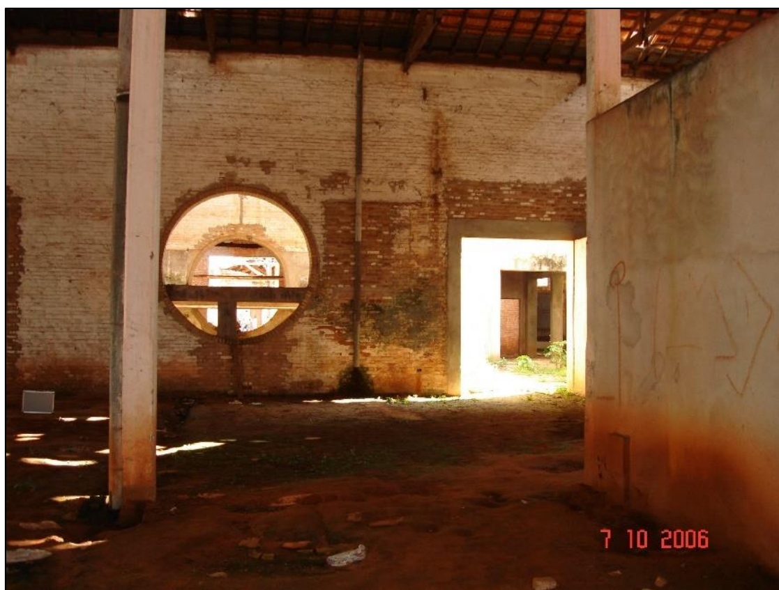
Figura 44 - Área interna do Bloco 1 antes da intervenção, 2006.
