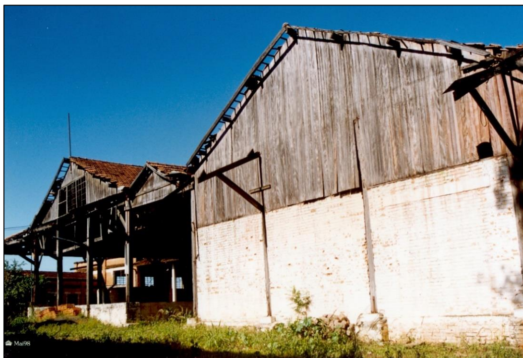
Figura 49 - Fachada norte do Bloco 2 em 1998
