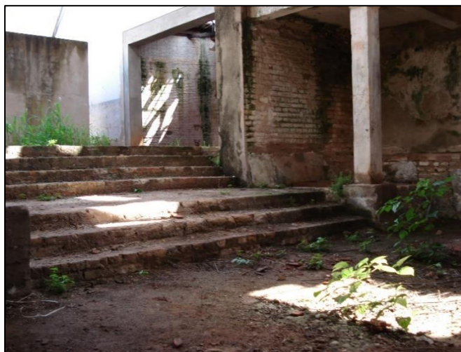
Figura 45 - Área da base das prensas no Bloco 1 antes da intervenção, 2006.
