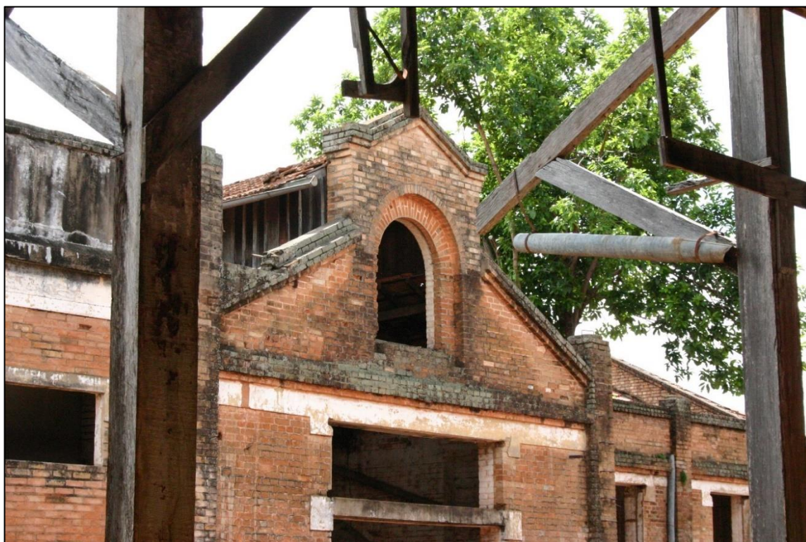
Figura 56 - Detalhe da fachada principal do Bloco 1.
