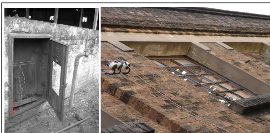
Figura 38 - Parte das instalações hidráulicas e elétricas
