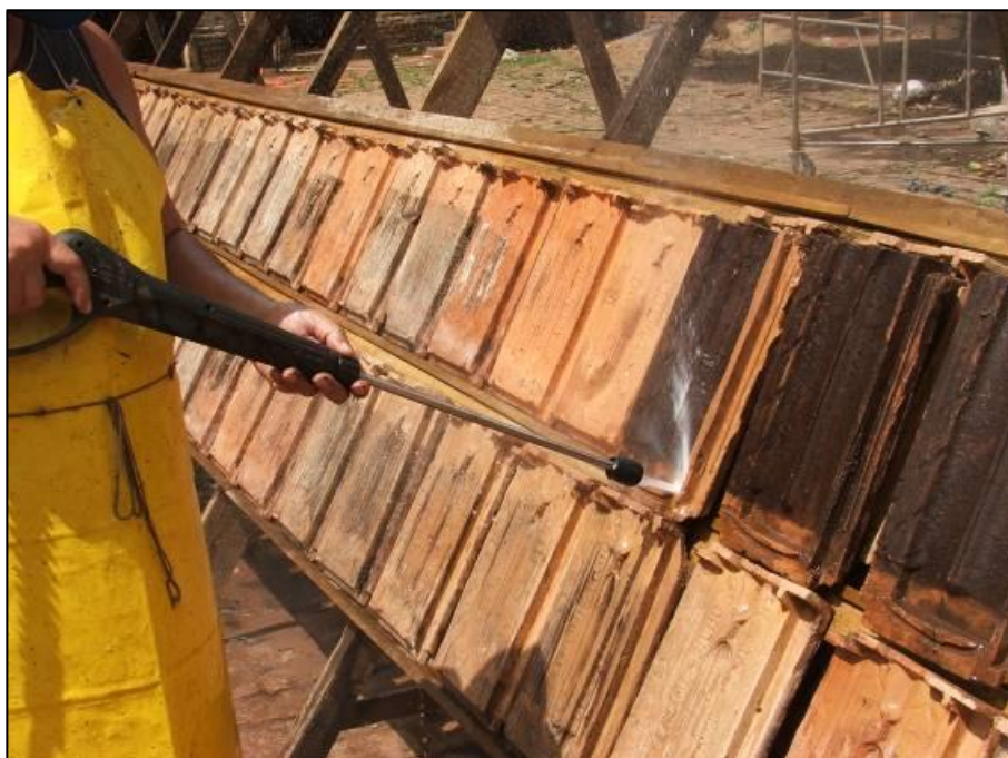
Figura 66 - Hidrojateamento executado na limpeza das telhas originais
