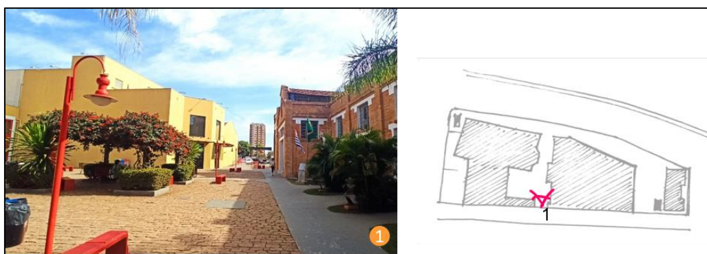
Figura 87 - Relação entre a nova construção (Teatro) e a antiga (Bloco 1)
