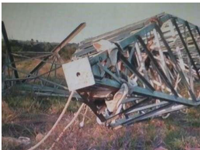
Figura 1 – Acidente que poderia ser evitado – Queda de torre mata seis trabalhadores peruanos em Rondônia. 2014.
