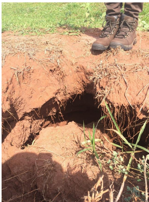
Figura 7: Um dos buracos descritos pelos assentados. Surgem em meio a pastagem, podendo-se observar que possuem extensão subterrânea considerável (Fonte: Arquivo Pessoal)
