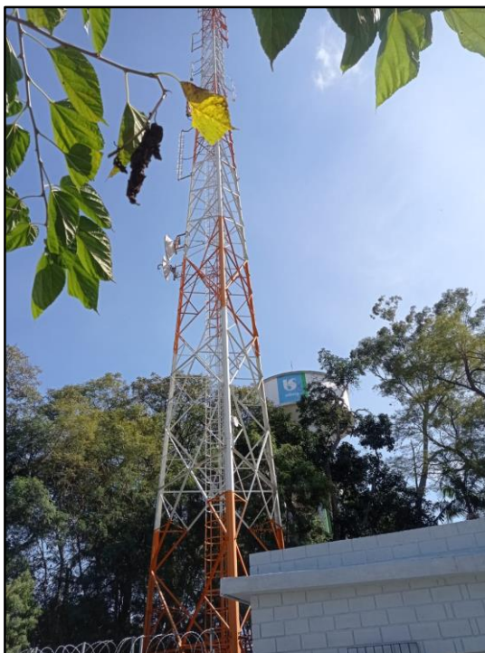
Figura 17 – Torre e antenas de transmissão de uma estação retransmissora de televisão.
