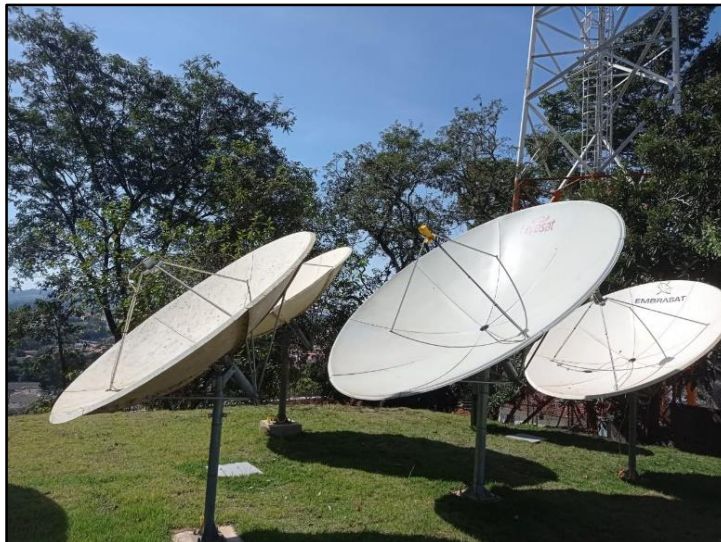
Figura 13 - Antena de recepção de satélite – Banda C.
