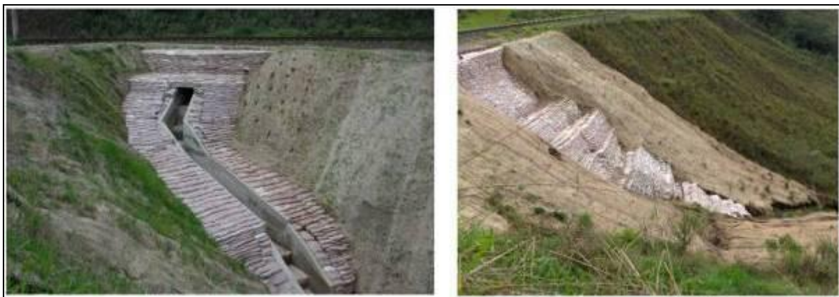
Figura 22a e 22b – Sistemas de revestimento com solo-concreto.
