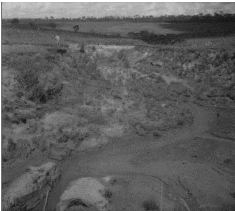
Figura 30 – Boçoroca na estrada de Rancharia para Bastos.
