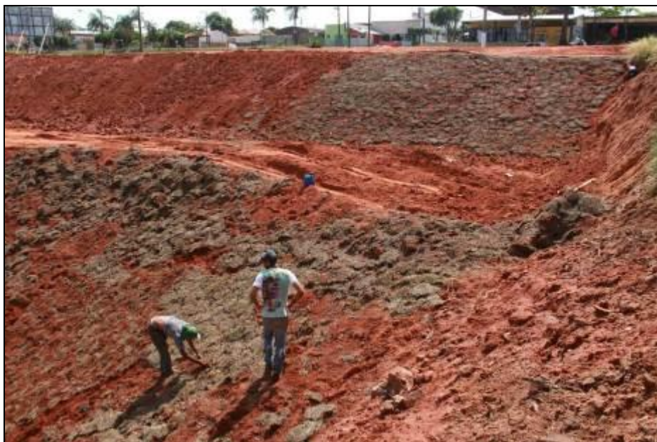
Figura 77 – Plantio de gramíneas em área aterrada.
