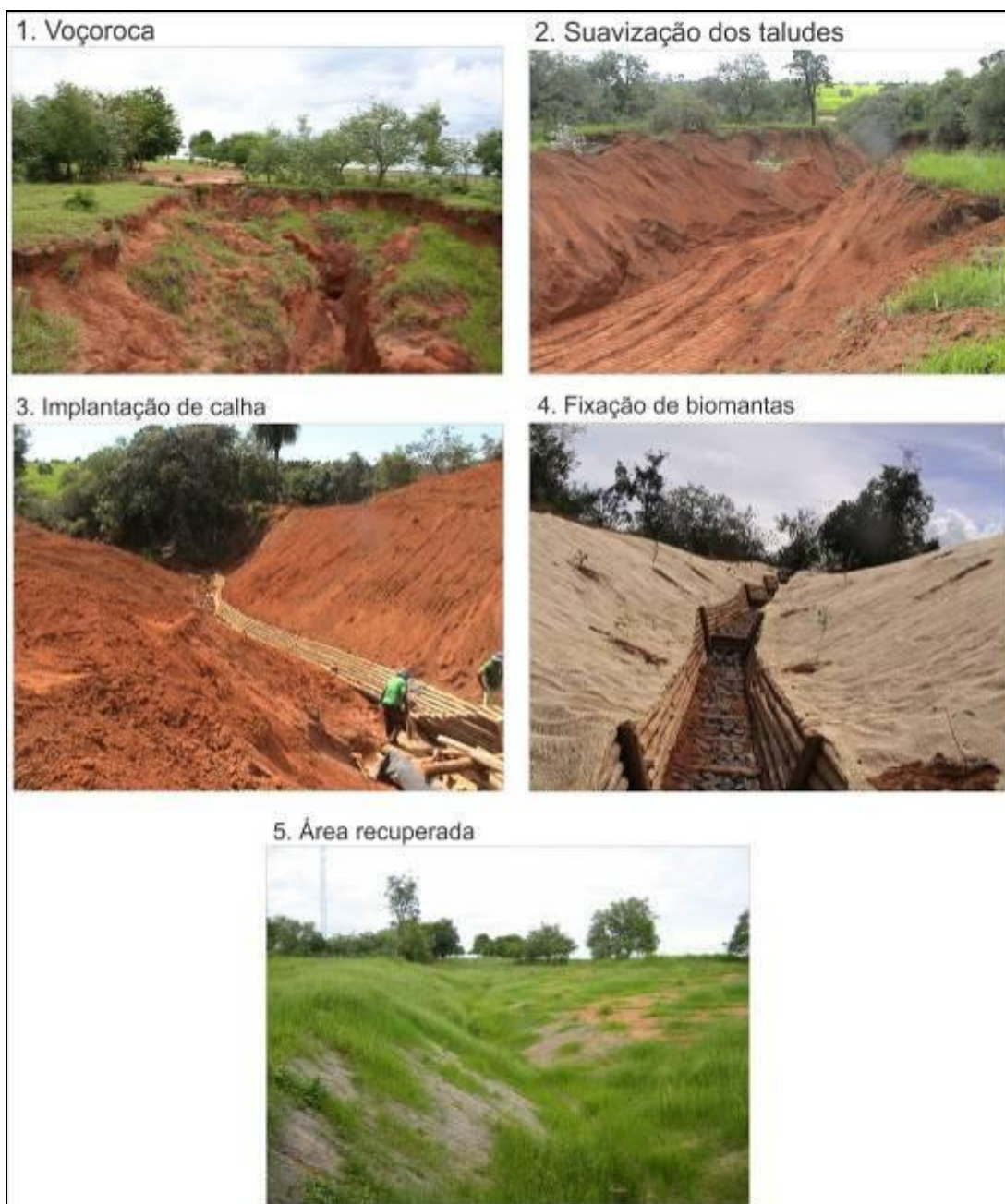
Figura 24a 24b 24c 24d 24e – Controle de boçoroca com técnicas de bioengenharia de solos.
