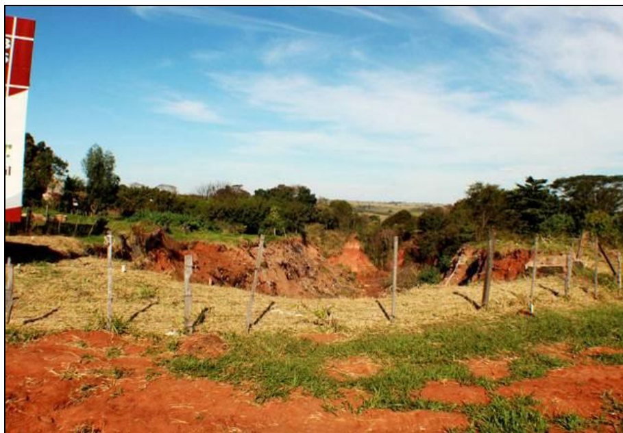
Figura 96 – Cabeceira da boçoroca próxima da cerca de divisa
