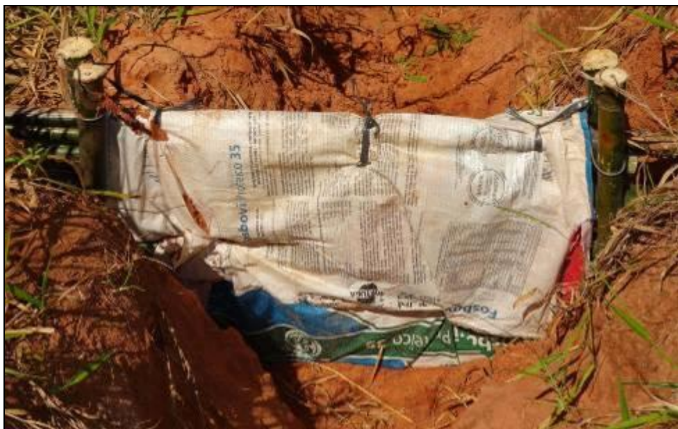
Figura 10 – Barreira com bambus impermeabilizados por rafia.
