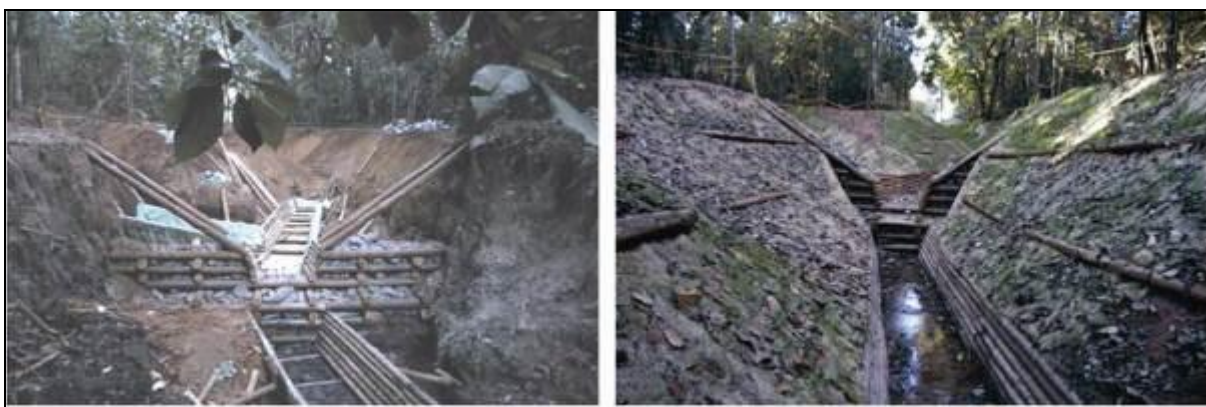
Figura 23a e 23b – Calhas construídas com madeiras e pedras.
