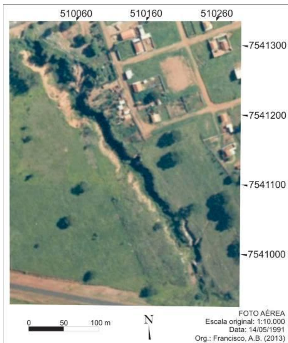
Figura 55 – Foto aérea da boçoroca do córrego do Grito (1991).
