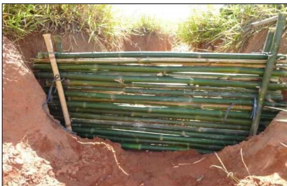
Figura 09 – Barreira com bambus na horizontal.
