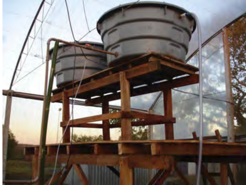
Figura 15. Altura das caixas de água elevada com o uso de uma mesa, para facilitar a realimentação dos CWSs em estudo.
