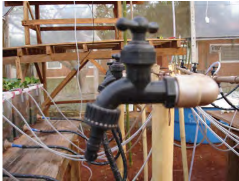
Figura 17. Detalhe do gotejador usado nos CWSs tipo ascendente, localizado na extremidade da torneira.
