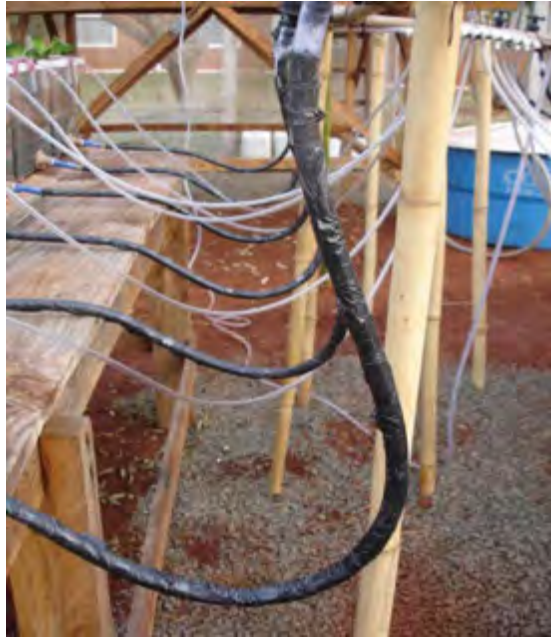
Figura 19. Mangueiras encapadas evitam a aparição de algas e seu entupimento.
