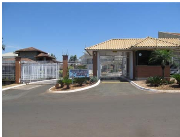
Foto 24: Condomínio Villaggio Ipanema
