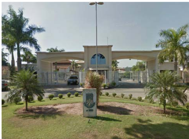
Foto 31: Condomínio Portal do Copacabana
