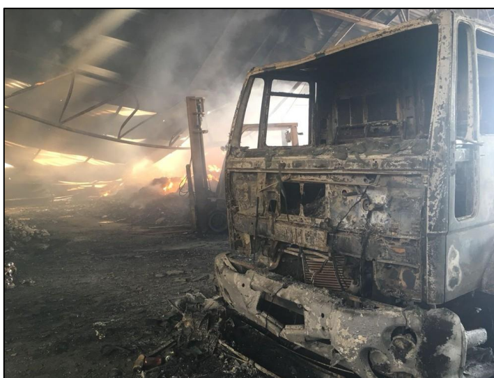
Figura 13 - Interior do barracão da Cooperlix após o incêndio de 2018, com veículos e equipamentos devastados
