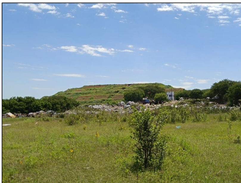
Figura 11 - Área do antigo lixão, posteriormente convertido em aterro controlado, atualmente desativado, em Presidente Prudente - SP
