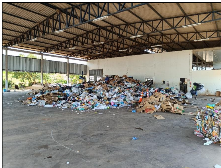
Figura 30 - Área externa do barracão destinada à descarga dos resíduos coletados
