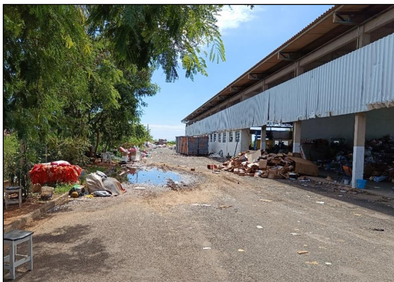
Figura 24 - Lateral do barracão com acúmulo de materiais recicláveis
