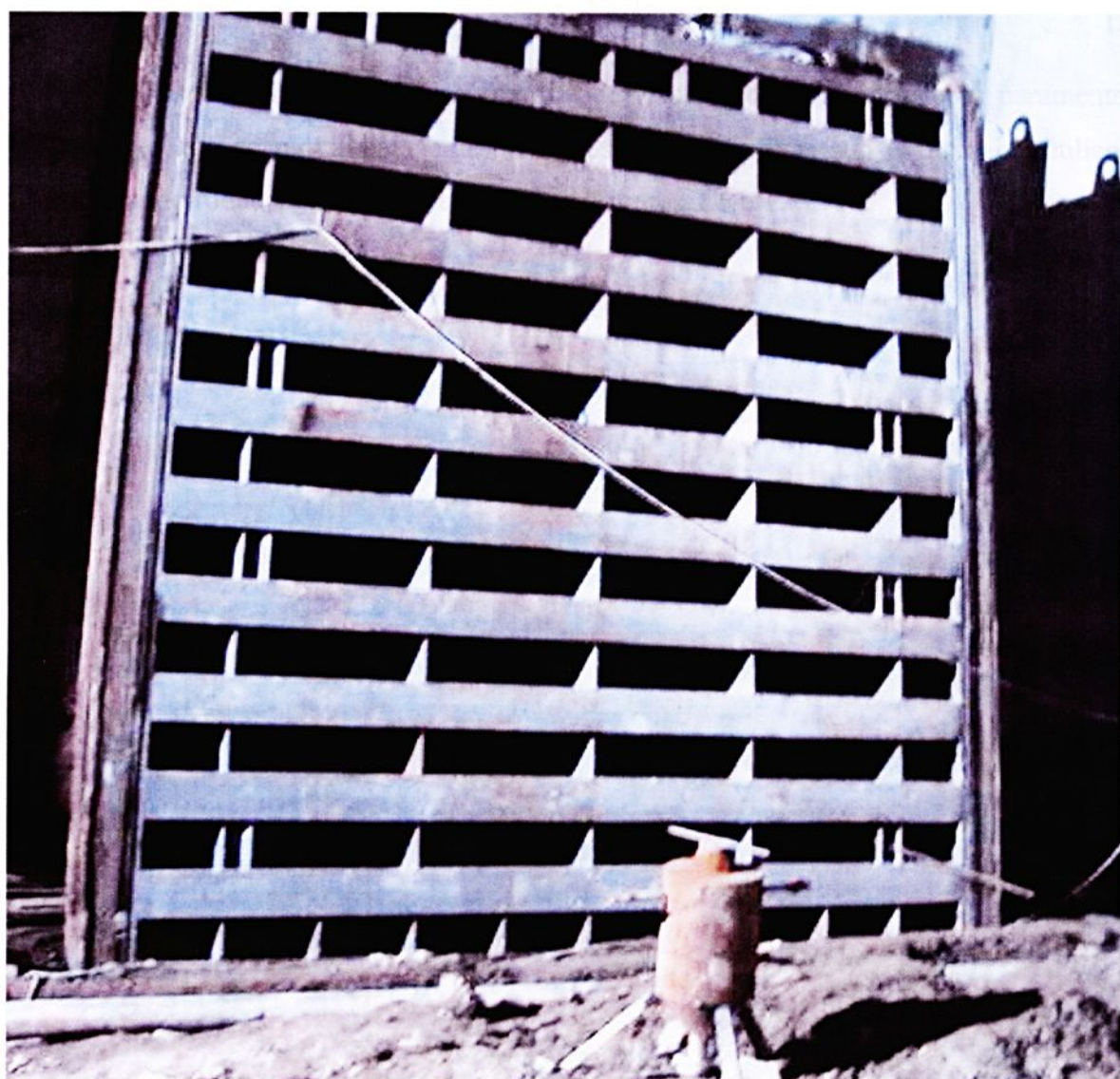
Figura 1.5 – Fotografia de uma comporta gaveta (deslizante) na obra.
