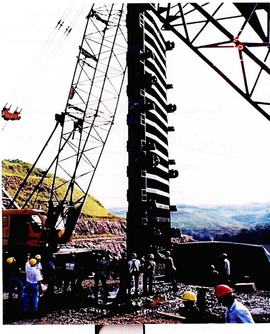
Figura 1.7 – Fotografia de uma comporta vagão em fase de montagem no campo.
