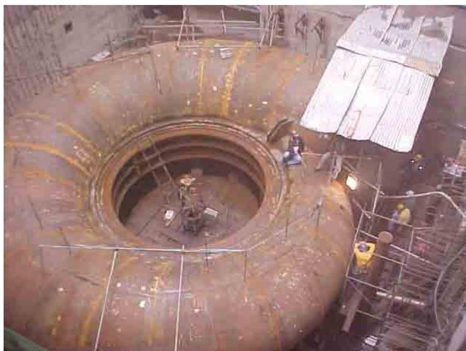
Figura 4.1 – Foto da vista parcial superior da caixa espiral da UHE Barra Grande.
