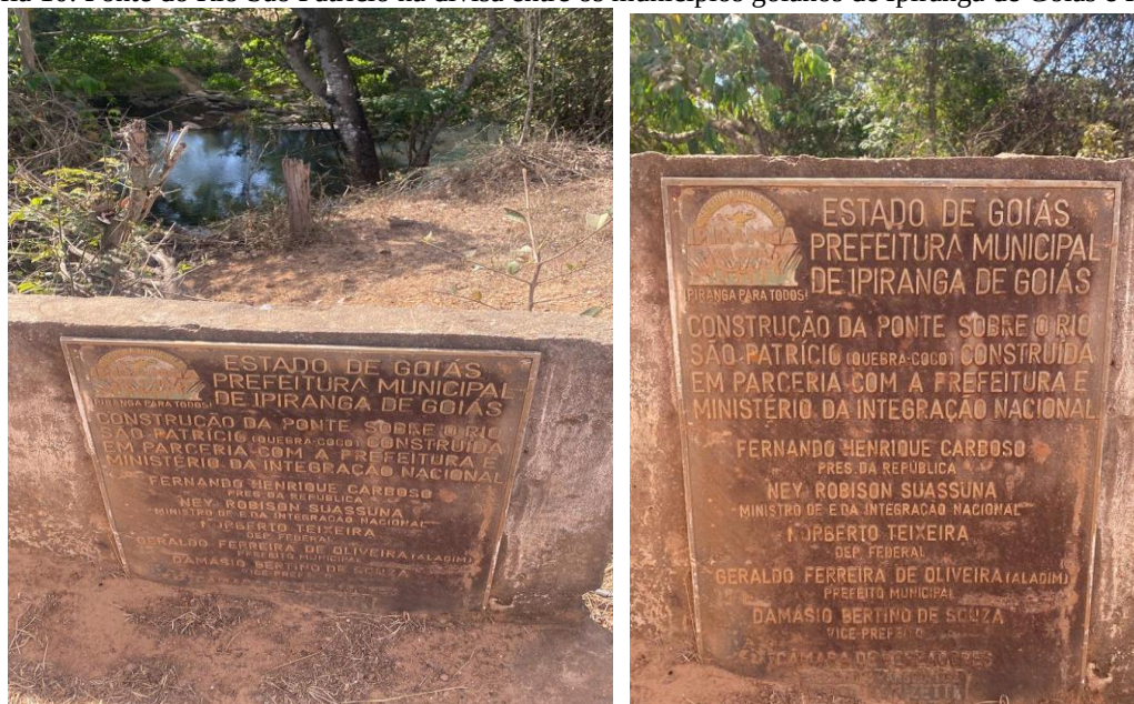
Fotografia 10: Ponte do Rio São Patrício na divisa entre os municípios goianos de Ipiranga de Goiás e Itapaci
