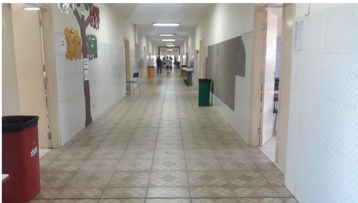
Corredor para salas de aulas
