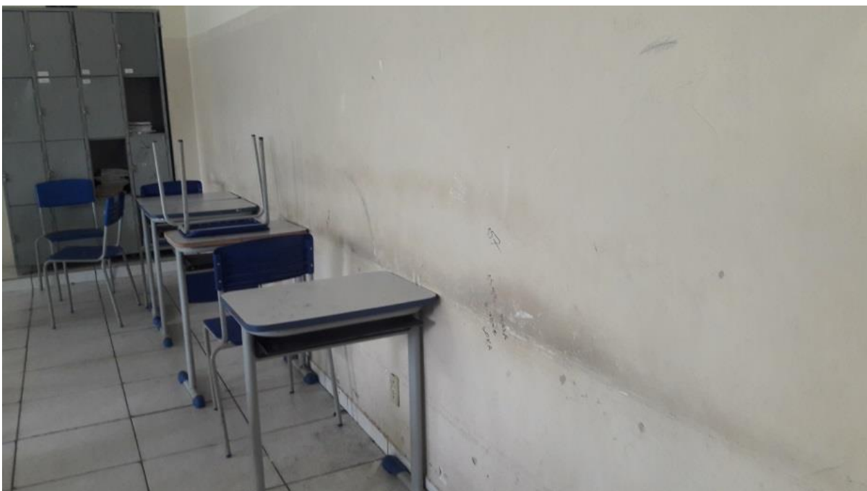
Paredes e armários
