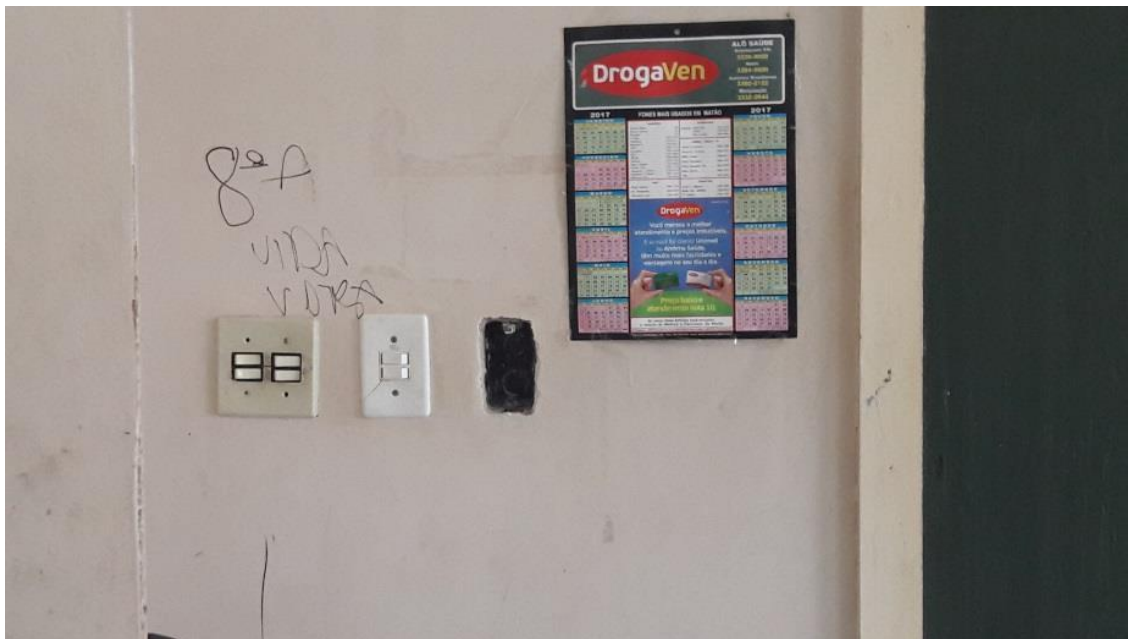
Paredes sala de aulas
