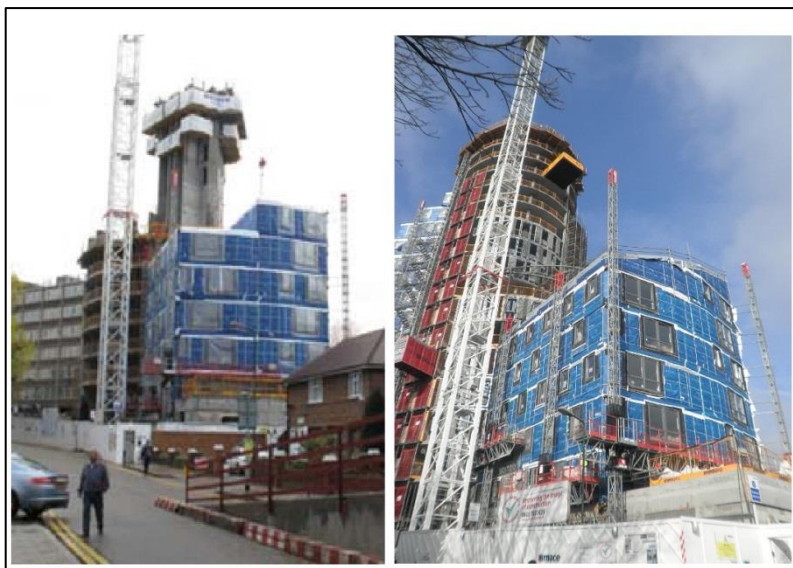
Figura 50 - Construção do núcleo de concreto e instalação dos módulos.
