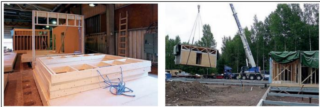
Figura 42 - Montagem e instalação dos módulos
