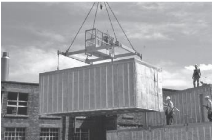
Figura 31 - Içamento de módulo
