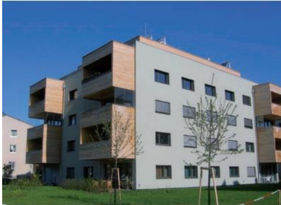
Figura 35 - Edificação Residencial em Mühlberg, Áustria.
