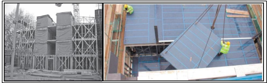
Figura 61 – Instalação dos módulos e das placas de piso.
