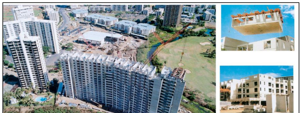
Figura 56 - Execução, içamento e locação dos módulos.
