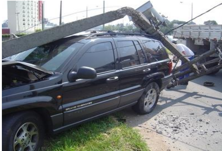
Figura 8. Abalroamento de poste. Foto: Copel
