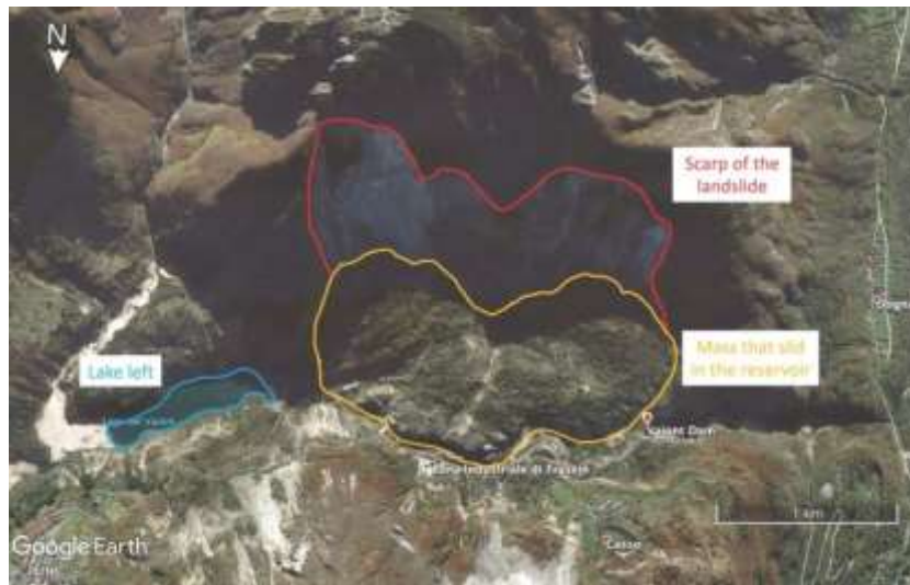
Figura 8 – Segundo deslizamento com volume entre 270 a 300 milhões de metros cúbicos
