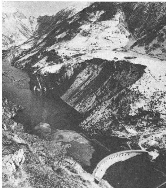
Figura 7 – Primeiro deslizamento – 700 mil metros cúbicos
