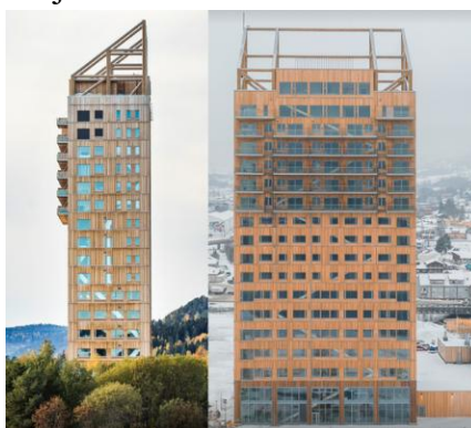
Figura 9 - Edifício Mjøstårnet construído com madeira engenheirada.
