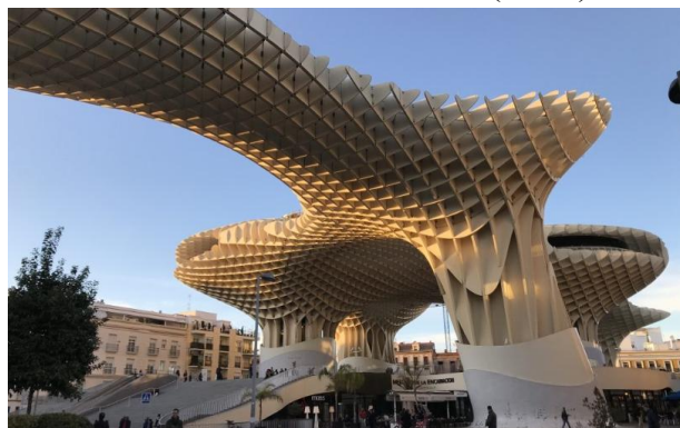
Figura 8 - Obra em madeira lamelada colada (MLC) Metropol Parasol.
