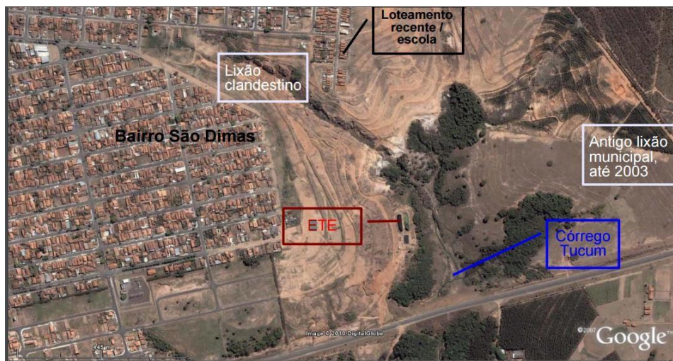
Figura 14: Obras da prefeitura em área de risco
