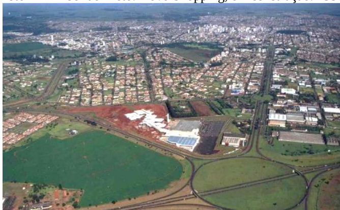
Foto 22 - Ribeirão Preto. Novo Shopping, em construção. 1998.
