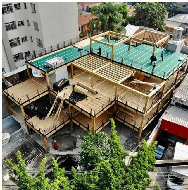
Figura 6 – Primeiro prédio em MLCC do Brasil durante sua construção.
