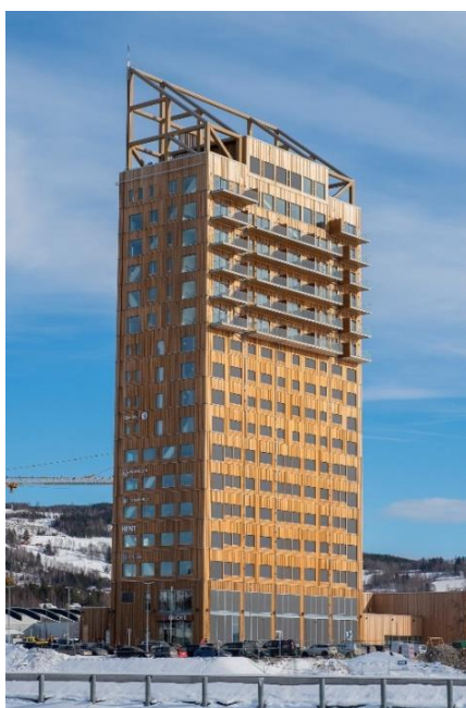
Figura 4 – Edifício Mjøstårnet, Noruega.
