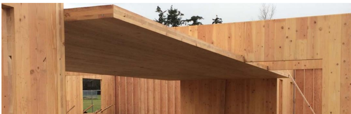
Figura 3 – Edificação construída com MLCC de três camadas.
