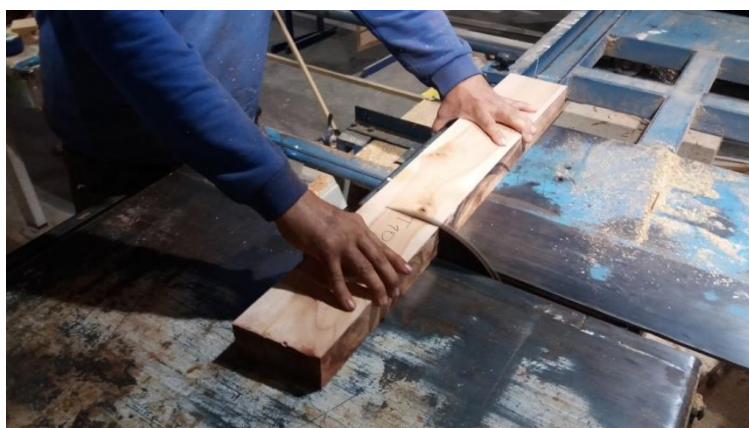
Figura 35 – Seccionamento das tábuas com uso de esquadrejadeira.
