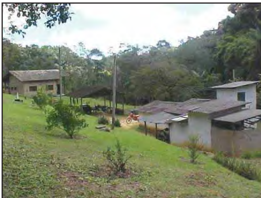
FIGURA 3.20 – Base Vargem Grande do PESH-Núcleo Santa Virgínia.
