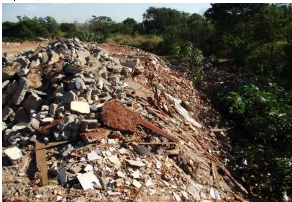
Figura 7 - Monte de Resíduos de Construção e Demolição (Vista Superior – Lateral Esquerda).
