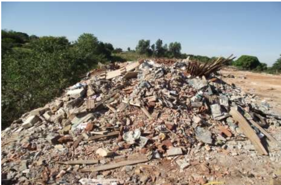
Figura 6 - Monte de Resíduos de Construção e Demolição (Vista Superior – Lateral Direita).
