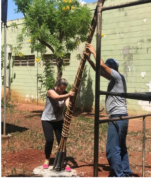
Figura 103 - momento do encaixe do pilar
