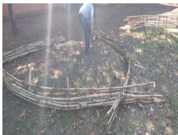
Fonte: elaboração do próprio autor Figura 74- colmos nas fôrmas durante o período de secagem e manutenção das amarrações
