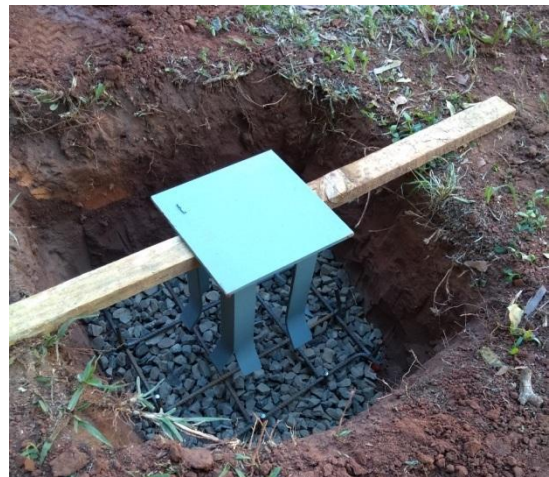
Figura 94 - Detalhe da instalação dos apoios utilizando o caibro
