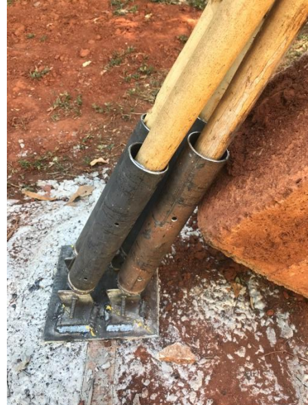
Figura 104 - detalhe do encaixe no cachimbo
