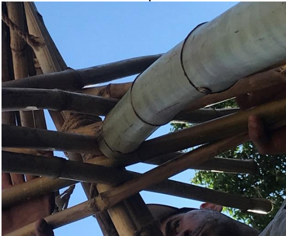
Figura 105 - entrelace dos colmos de ambos pilares
