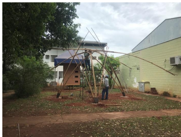
Figura 112- montagem das cumeeiras
