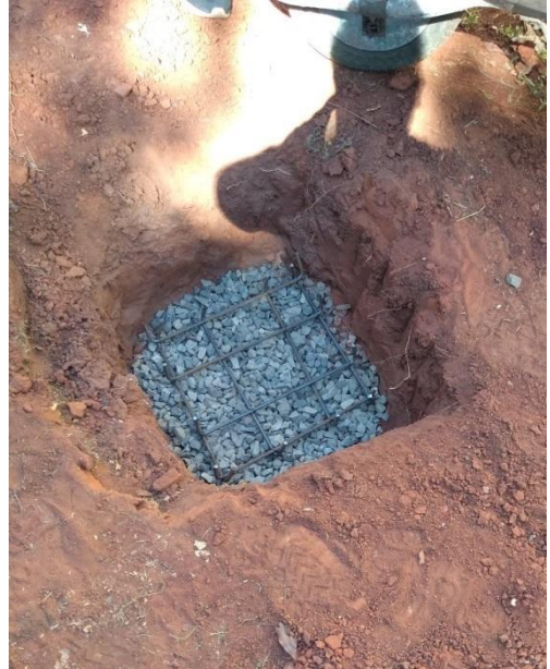
Figura 92- Detalhe do lastro e armação
