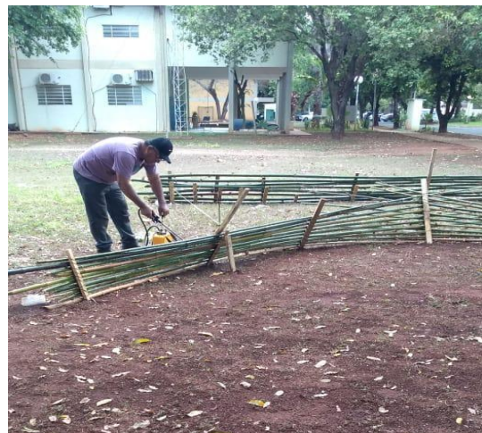
Figura 72 - aspersão da solução de octaborato
