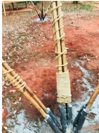
Figura 118- acabamentos realizados na estrutura
