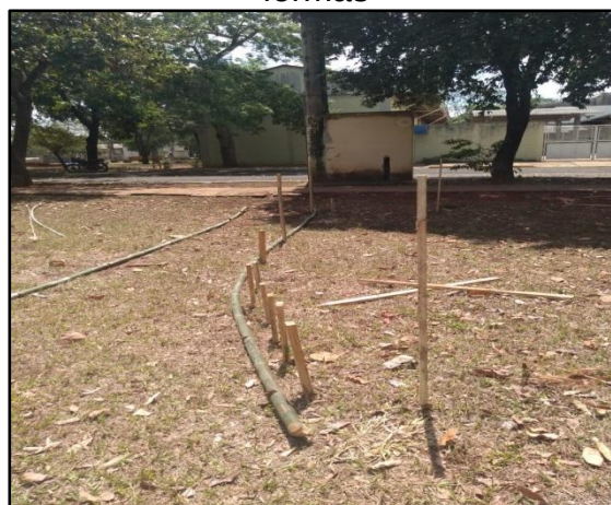
Figura 70 - organização dos colmos nas fôrmas
