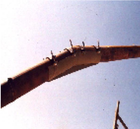
Figura 22- luva de união e inclinação da calota
