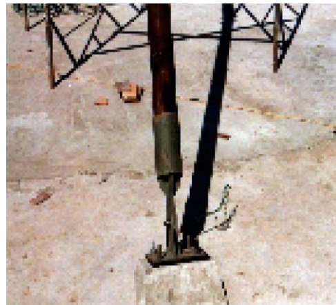
Figura 21 - luva metálica em forma de cachimbo
