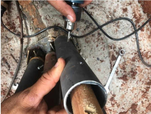
Figura 107- aparafusamento do colmo
