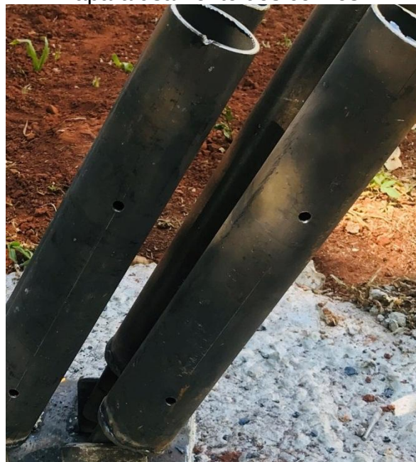
Figura 100 - detalhe dos furos para aparafusamento dos colmos
