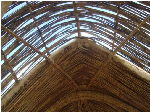
Figura 12 - Detalhe da cobertura com amarrações de bambu
