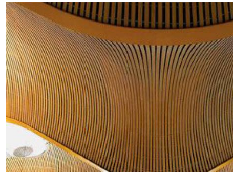
Figura 2 - Forro do Aeroporto Internacional de Barajas (Espanha)
