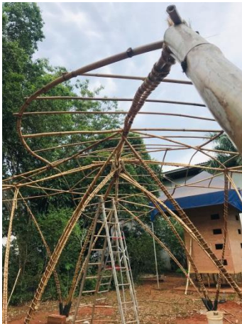
Figura 117- retirada das escoras
