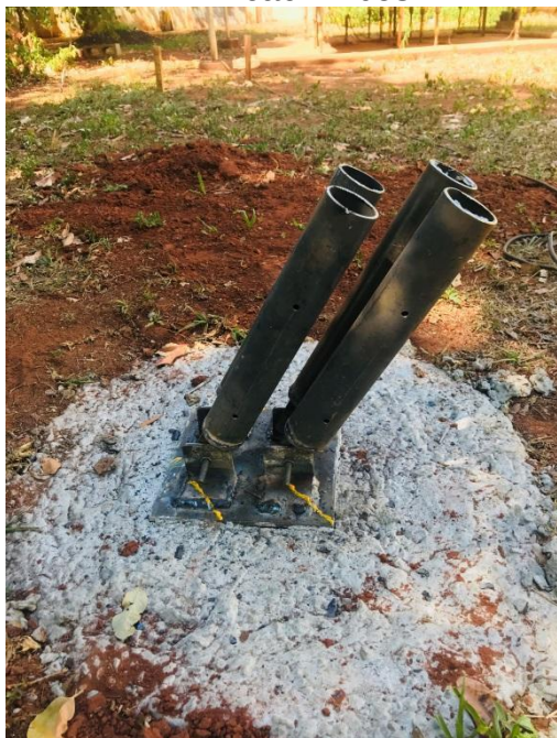
Figura 99- detalhe da angulação dos cachimbos
