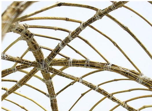
Figura 61- Detalhe da ligação dos pilares
