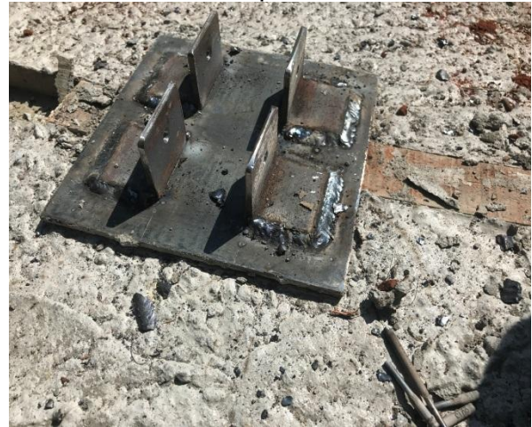
Figura 96- apoio metálico inserido à sapata
