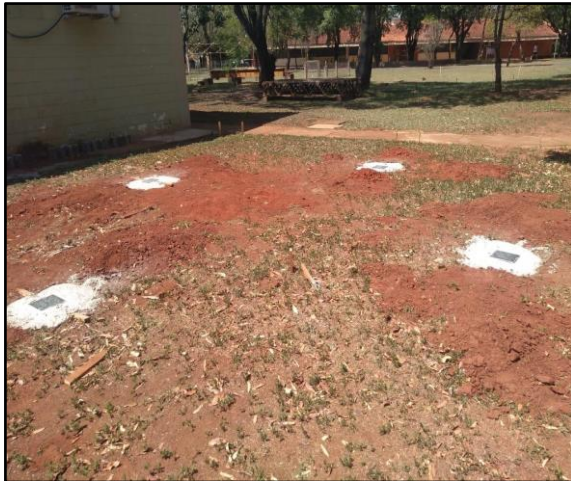
Figura 95 - sapatas concretadas
