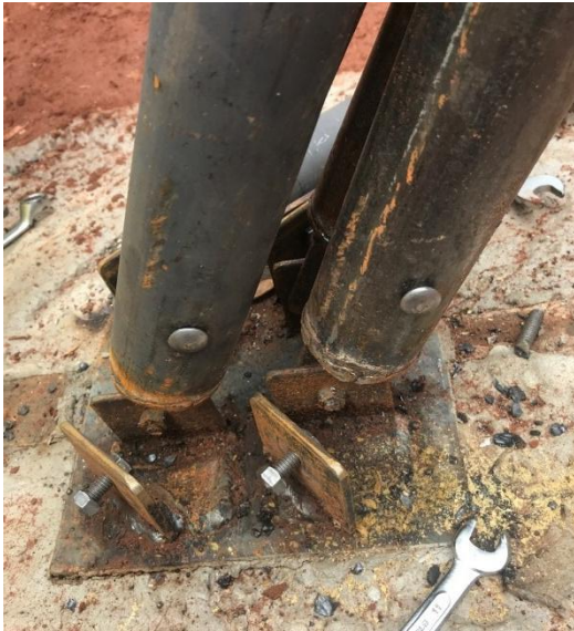
Figura 97- fixadores metálicos instalados a 90° e 45°
