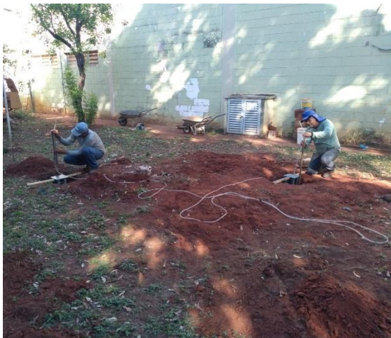
Figura 93 - Instalação dos apoios metálicos com auxílio da mangueira de nível
