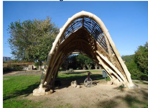
Figura 13- Cobertura vernacular em bambu e argamassa cimentícia
