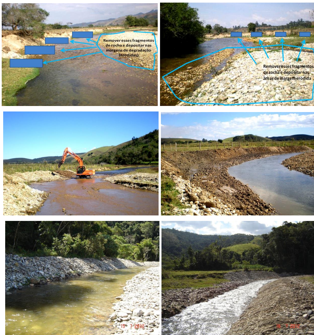
Figura 27 - Desassoreamento do leito e reconstrução das margens na área experimental do ribeirão Guaratinguetá, no período de 13 a 17 de agosto de 2012.
