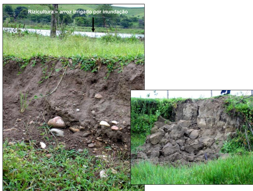
Figura 18 - Gleissolo em área de várzea, ocupada com rizicultura, altamente susceptível a processos erosivos.
