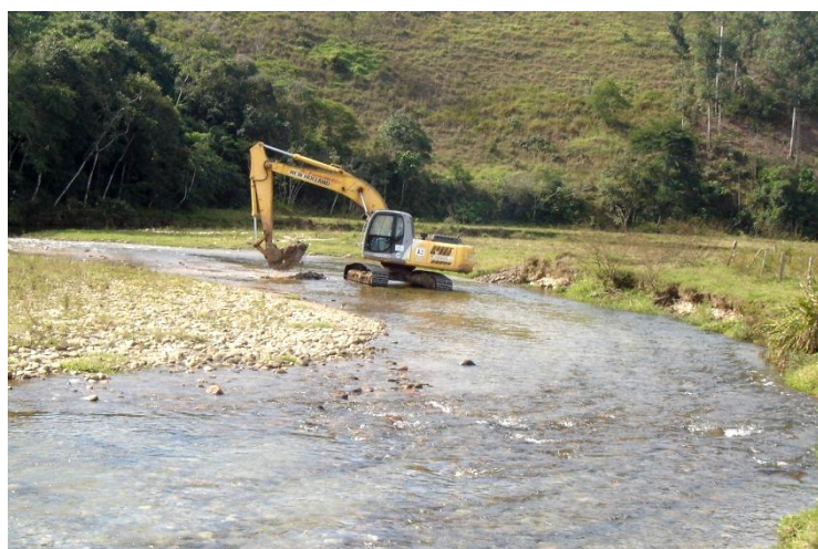
Figura 26 - Início do desassoreamento do leito do ribeirão Guaratinguetá no trecho da área experimental, no período de 09 a 13 de julho de 2012.
