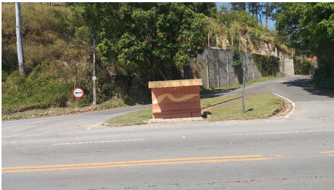
Figura 17. Parada de ônibus (SR-IT) – Volta Grande (São Roque)
