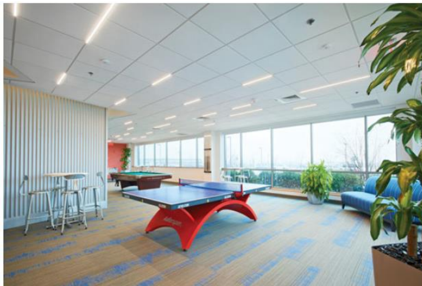
Figura 3.2 – Aplicação da iluminação LED por 24 V
