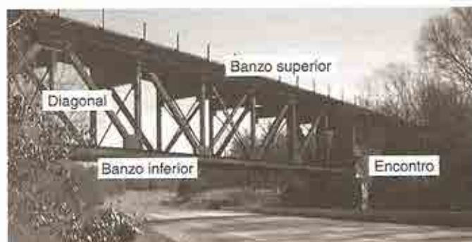
Figura 5 – Alguns componentes de uma ponte ferroviária (MCCORMAC, 2009)
