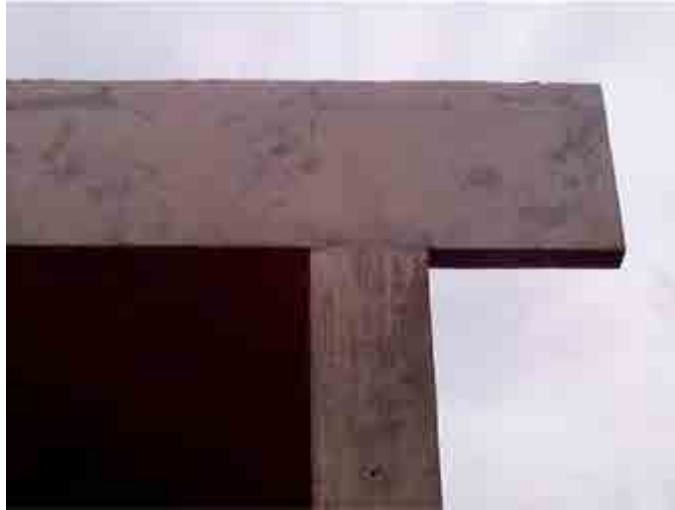
Figura 15 – Engastamento em uma estrutura de concreto ( http://www.fec.unicamp.br/~fam/novaes/public_html/iniciacao/teoria/reacoes/7.htm )
