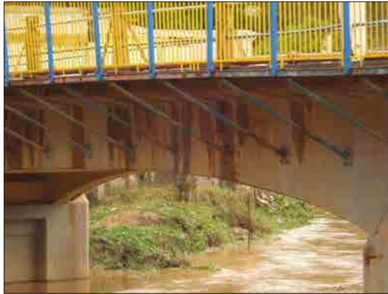
Figura 24 – Vista lateral da longarina a jusante (fonte: autor)
