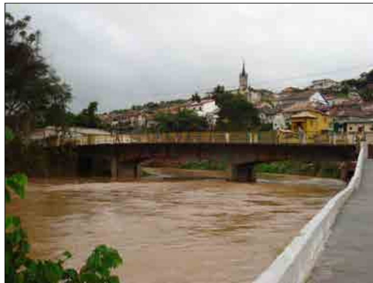
Figura 23 – Vista geral a jusante da ponte (fonte: autor)
