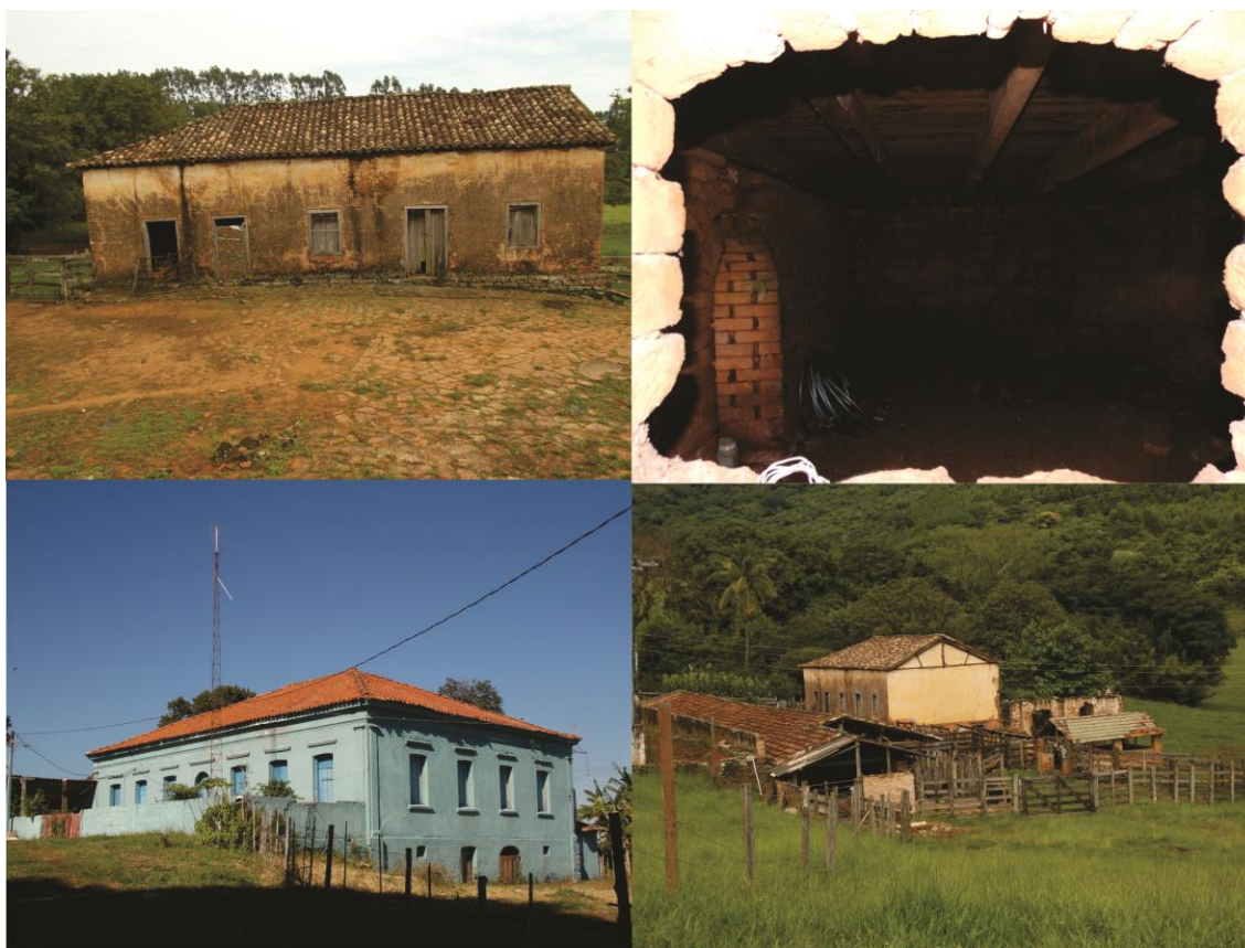
Figura 15: Casarões antigos encontrados na área rural de Ipeúna-SP
