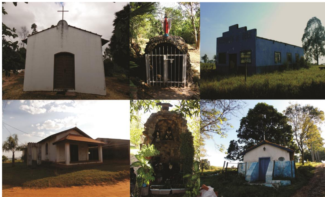
Figura 16: Construções religiosas em área rural de Ipeúna/SP
