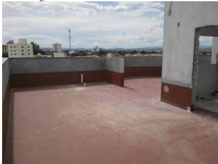
Figura 46 - Área externa da cobertura do final 1.
