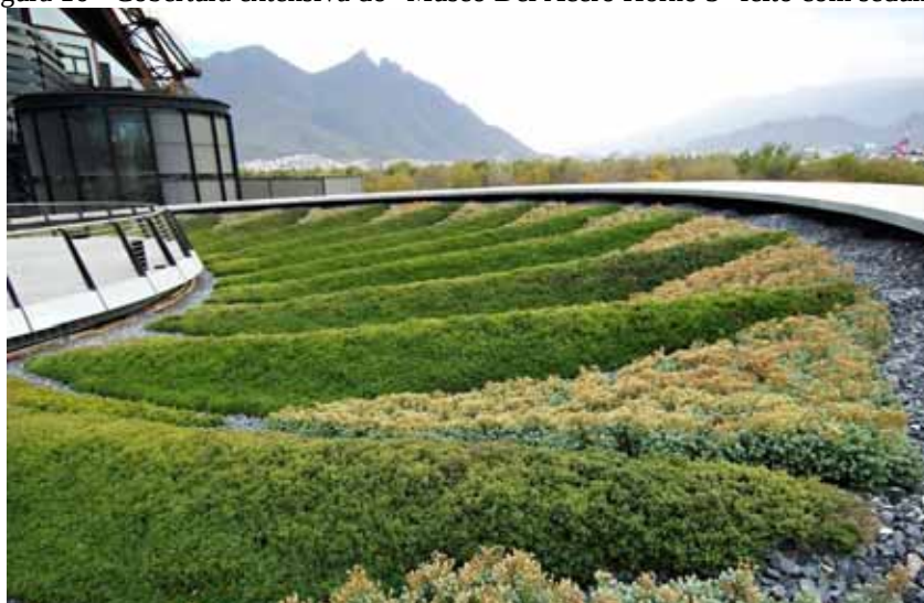
Figura 16 - Cobertura extensiva do "Museo Del Acero Horno 3" feito com sedum
