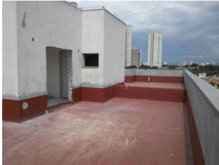
Figura 45 - Área externa da cobertura referente ao final 1 e ao fundo do final 3.
