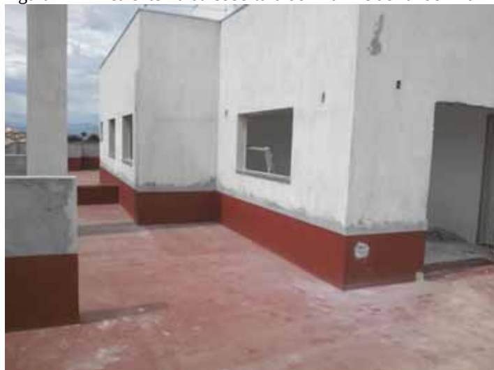
Figura 47 - Área externa da cobertura do final 1 e ao fundo final 2.
