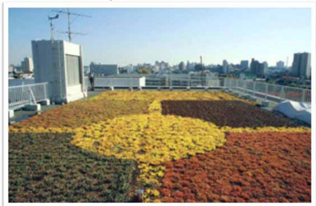
Figura 9 - Cobertura verde extensiva
