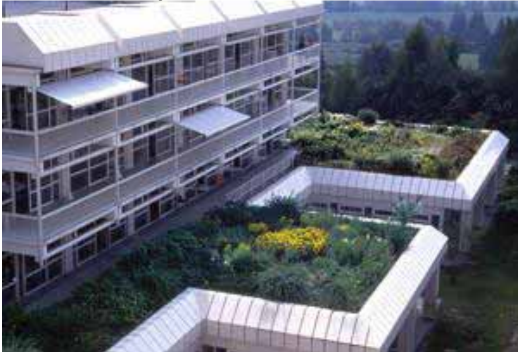
Figura 12 - Cobertura verde semi-intensiva
