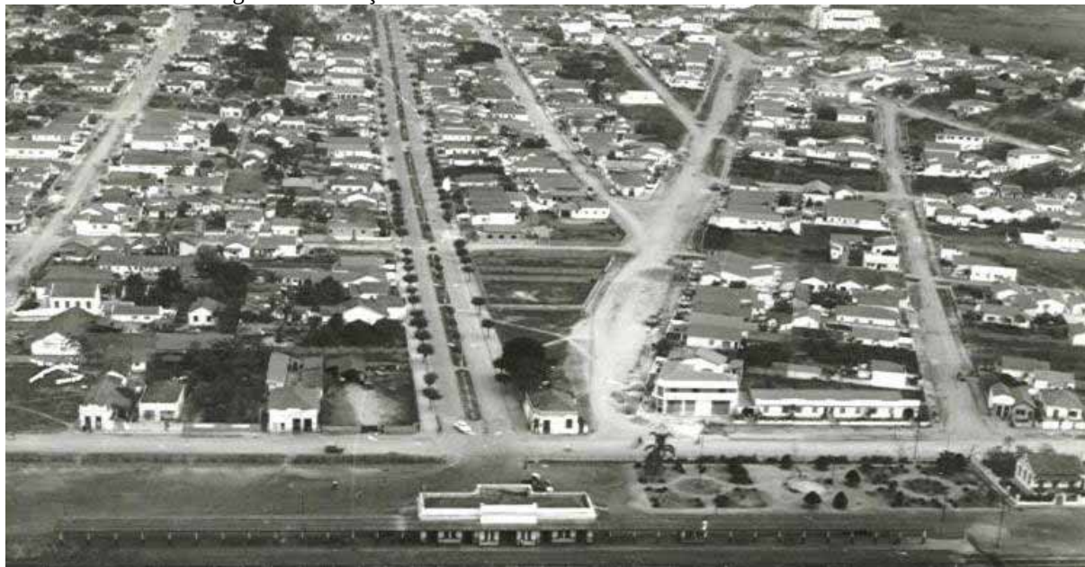
Figura 25 - Estação da Estrada de Ferro Central do Brasil e arredores.
