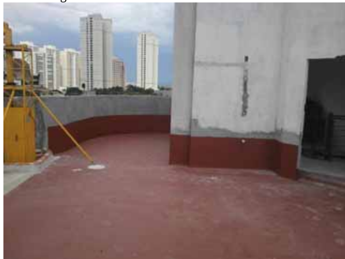
Figura 50 - Área externa da cobertura do final 2.
