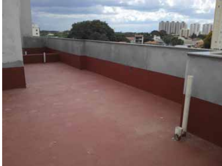
Figura 48 - Área externa da cobertura do final 2 e ao fundo divisa com o final 1.
