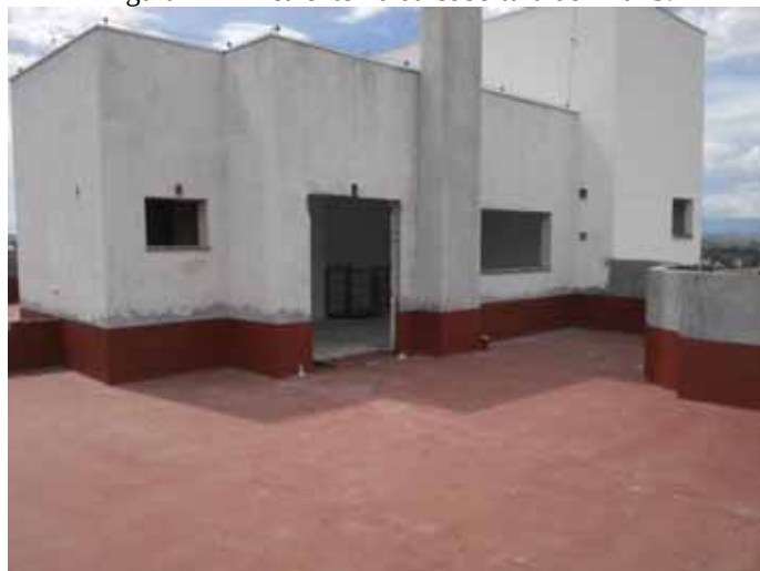
Figura 44 - Área externa da cobertura do final 3.
