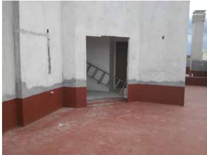
Figura 49 - Área externa da cobertura do final 2 e ao fundo, lado direito, final 1.
