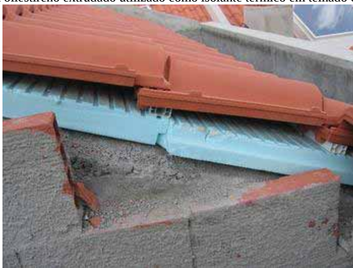
Figura 19 - Poliestireno extrudado utilizado como isolante térmico em telhado convencional
