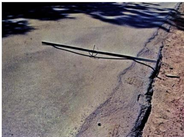
Figura 9 – Afundamento
